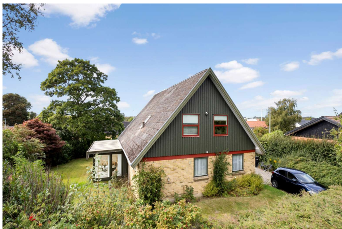
Facade set fra haven
