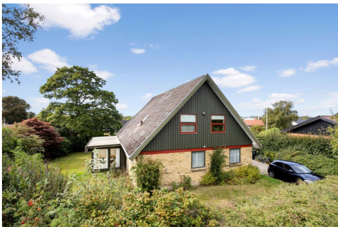
Facade set fra haven
