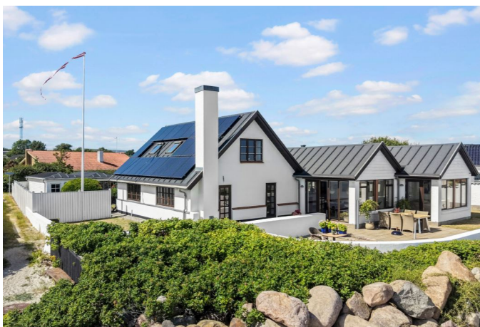
Facade set fra vandsiden
