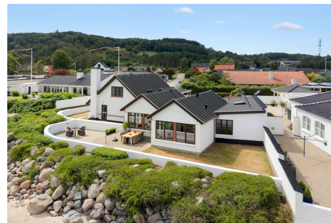
Facade set fra vandsiden
